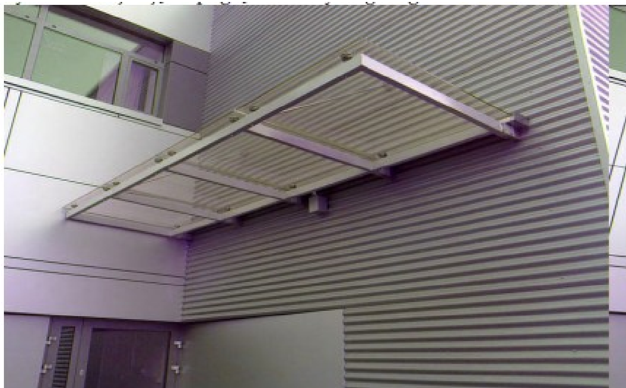
Rys. 4 - daszek zewnętrzny na profilach aluminiowych
