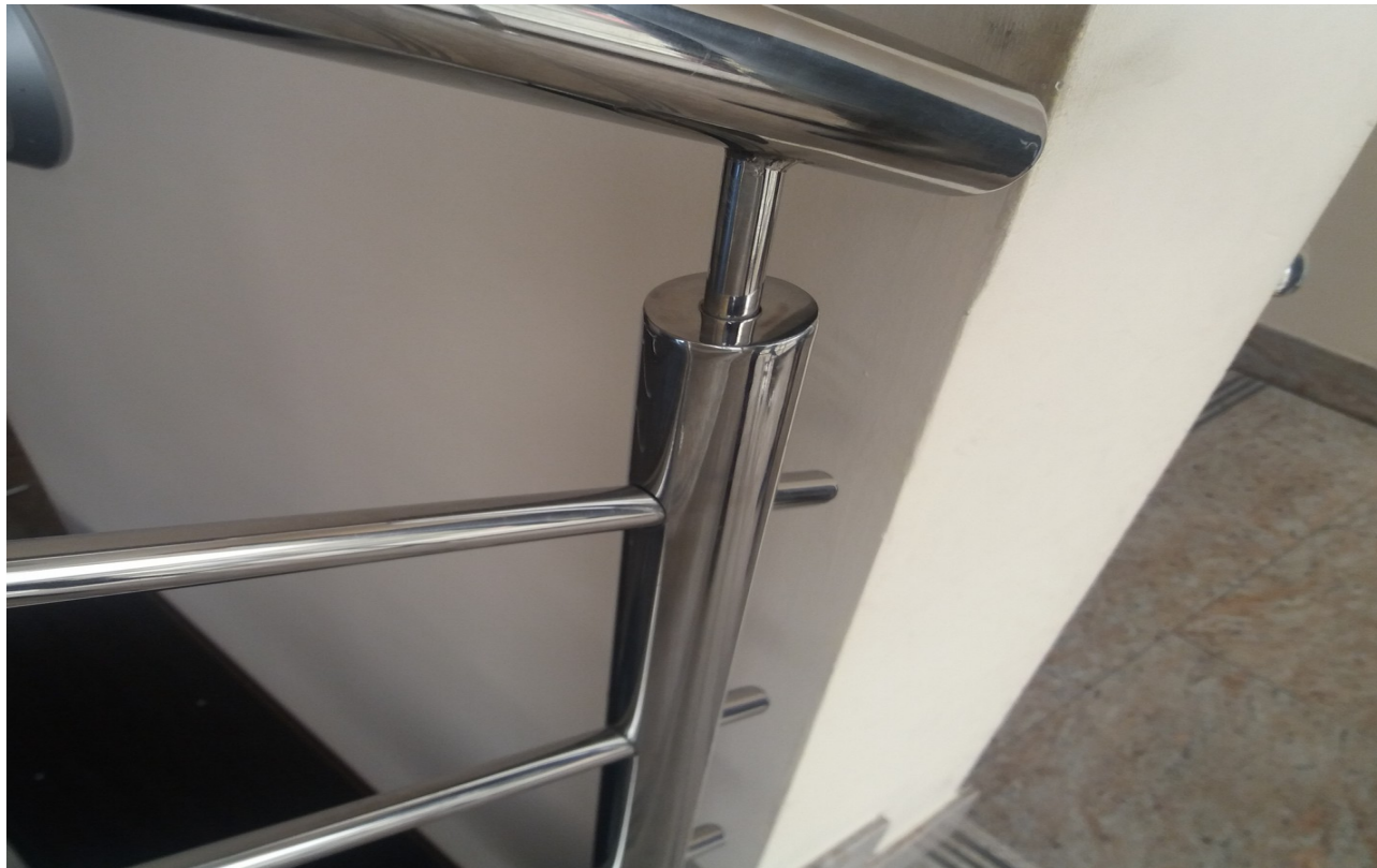
Rys. nr 2 - szczegół wykonania przelotki w barierze
