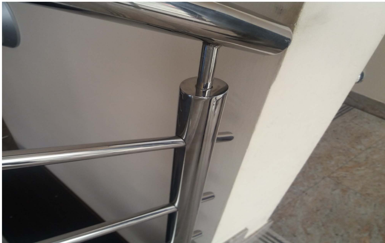
Rys. nr 2 - szczegół wykonania przelotki w barierce
